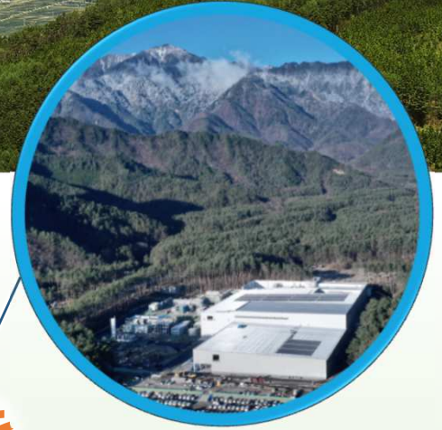
サントリー天然水北アルプス信濃の森工場 令和元年度助成金認定事業
